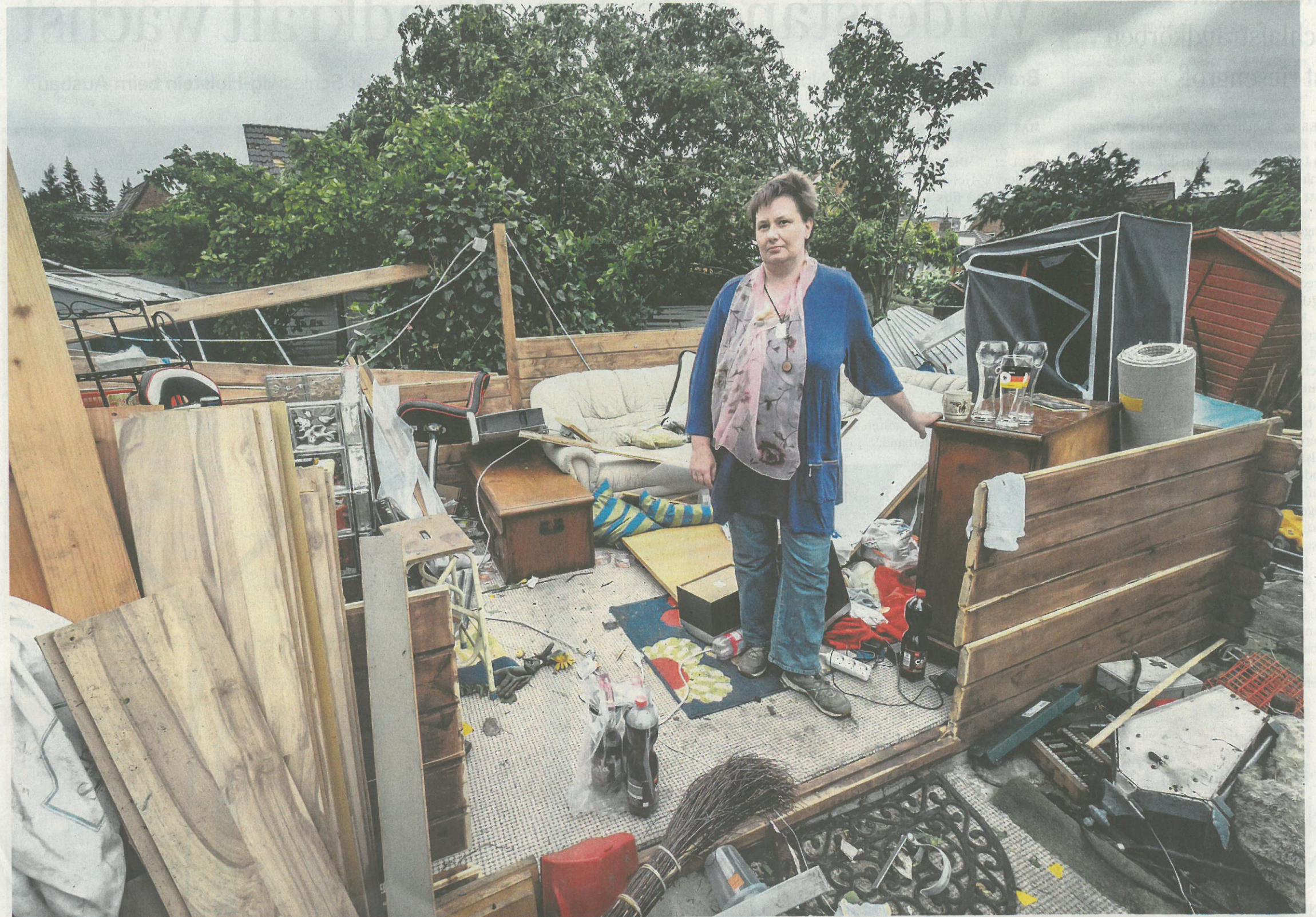
Von der neuen Gartenlaube ist kaum etwas stehen geblieben. Cornelia Bollmann saß im Inneren, als ihr der Sturm das Dach über dem Kopf wegriss. Sie hatte Todesangst
