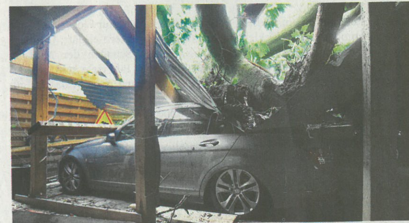
An der Farmsener Höhe zerschlug eine mächtige Eiche ein Carport-Dach. Die Autos darunter haben nur noch Schrottwert
